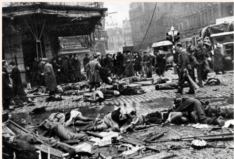
V2-bom op het kruispunt van de Teniersplaats, 27 november 1944
